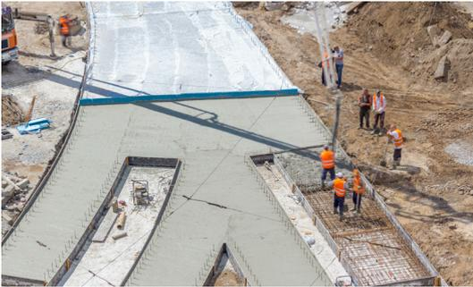
Queste ultime rappresentano una soluzione ibrida, in quanto la funzione portante è affidata ad una lastra in calcestruzzo ad armatura continua sormontata da uno strato di usura e scorrimento realizzato in “asfalto drenante”.
